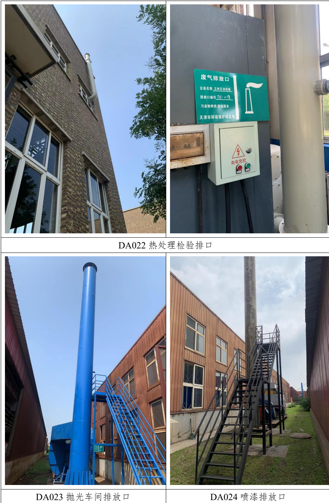
图 3.1-9 企业废气排放口
